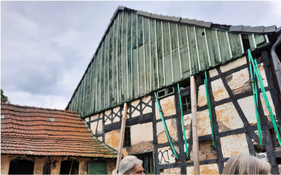
Die gesicherte Giebelseite des Kottens mit dem Dach des ehemaligen Kuhstalls, der zukünftigen Küche
