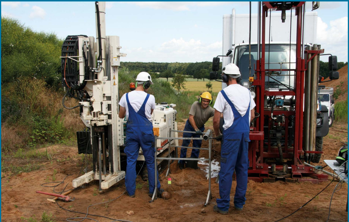
Einsatz des Direct Push-Verfahrens zur Untergrunderkundung
