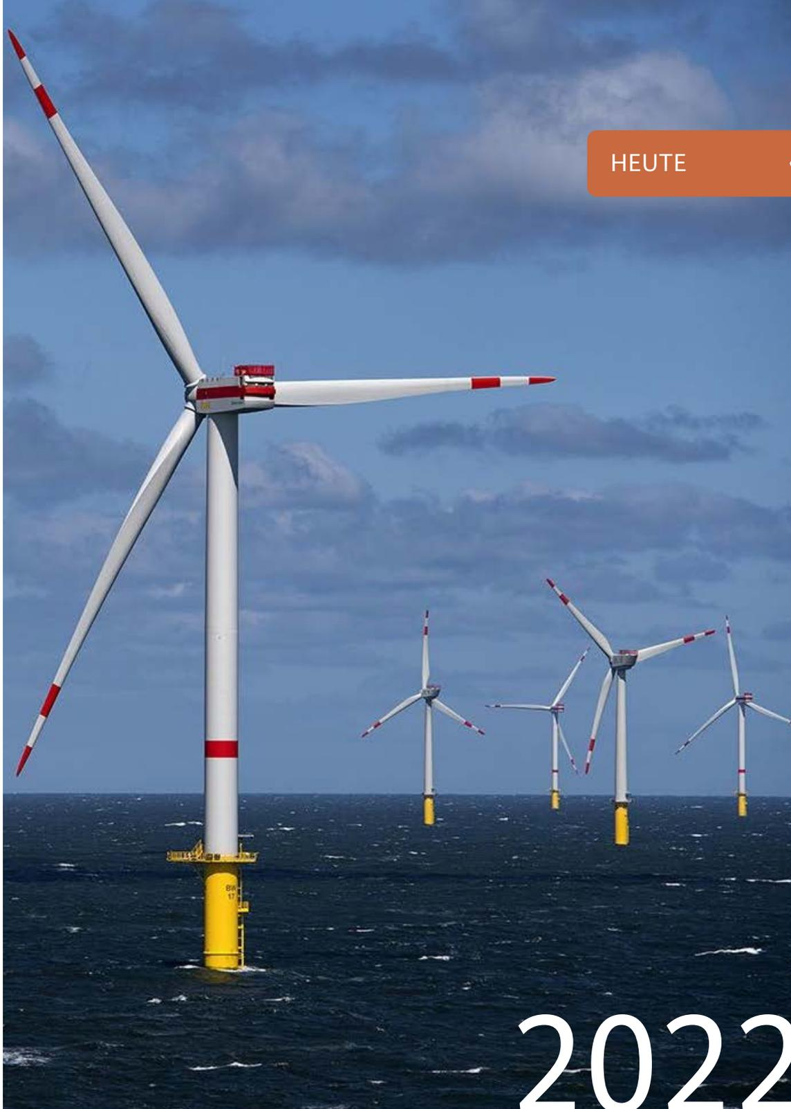
... liefern über 1.500 Offshore-Windenergieanlagen vor der deutschen Nord- und Ostseeküste grünen Strom. Die neuesten sind mit durchschnittlich 150 Meter Rotordurchmesser und über 6,8 Megawatt Leistung echte Power-Pakete. Um Stürmen zu trotzen, werden die Turmfundamente in bis zu 44 Meter Wassertiefe installiert. Die Stromproduktion der Offshore-Windparks ist beachtlich. 2021 haben sie mit 25 Mrd. Kilowattstunden rund ein Zehntel des Stroms aus regenerativen Energiequellen erzeugt.
