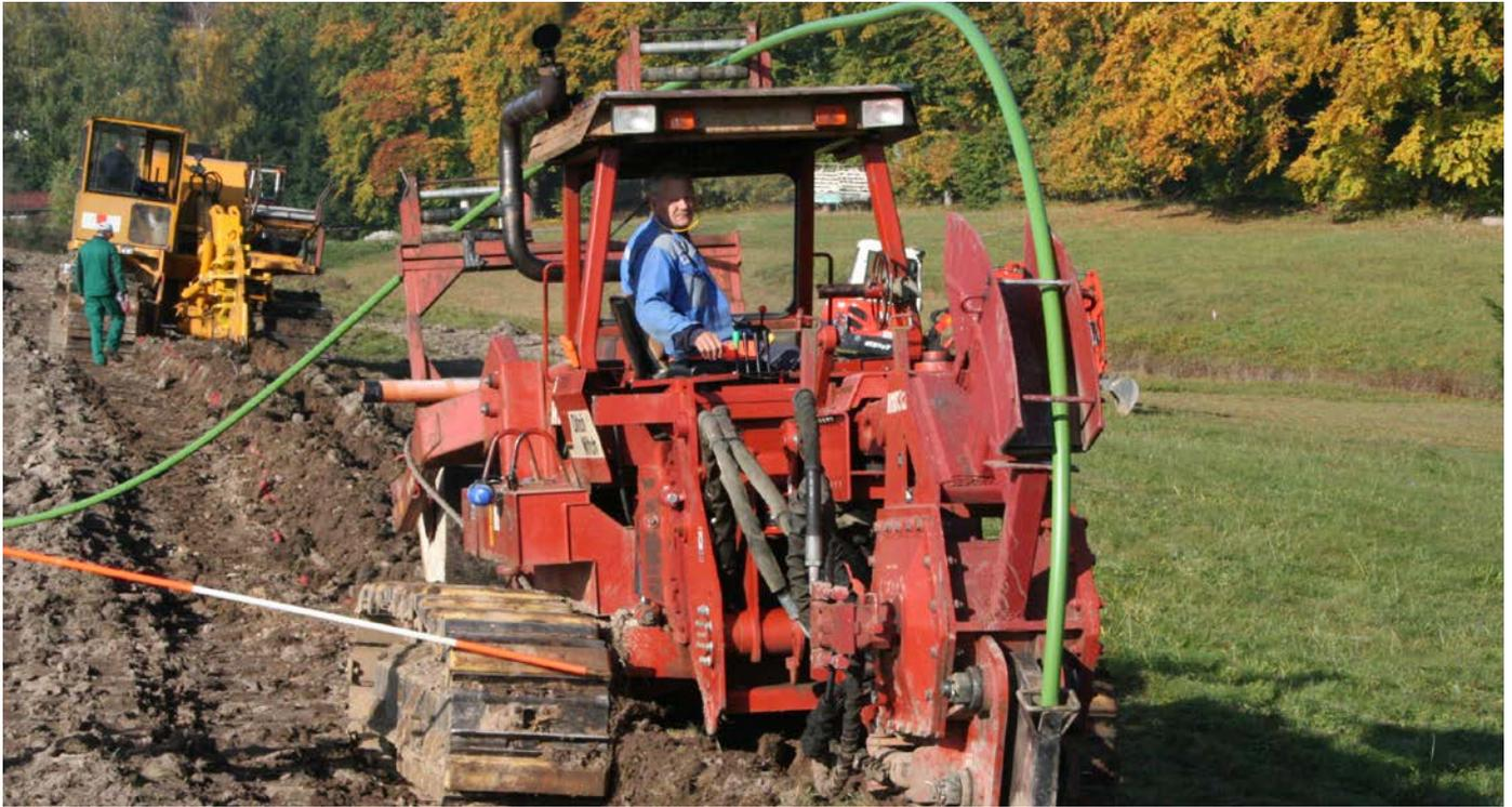
Die Agrothermiekollektoren werden mit einem Kabelpflug in den Boden eingepflügt, sodass die Fläche weiterhin landwirtschaftlich genutzt werden kann.
