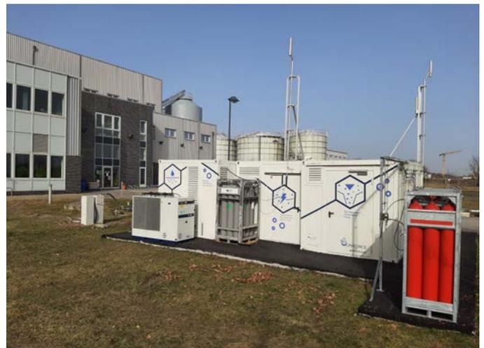
Die Pilotanlage in Waßmannsdorf: Hier wird mittels Plasmalyse aus industriellem Schmutzwasser Wasserstoff erzeugt.
