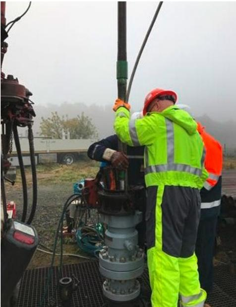
Abb. 11: Installation des MDA
