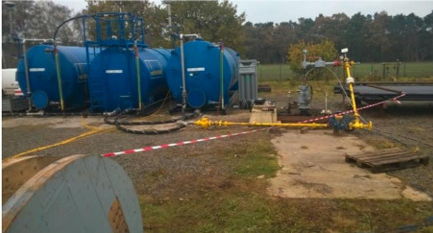
Abb. 12: betriebsbereite Förderanlage mit Absperreinrichtungen und Tankanlage
