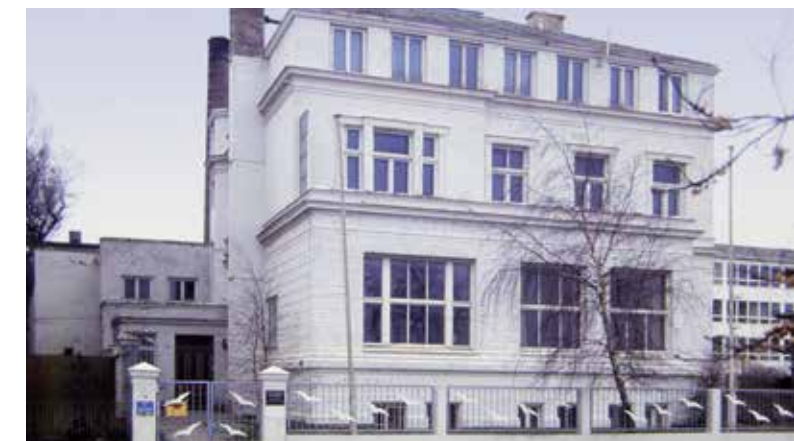
Heinkel-Villa, erster Standort der Rostocker Geschäftsstelle, 1991
