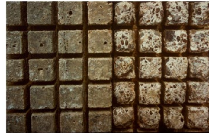
Abbildung 2: Vergleich eines gegen biogene Schwefel-Korrosion widerstandsfähigen mit einem wenig widerstandsfähigen Beton (Quelle Uni Duisburg Essen)
