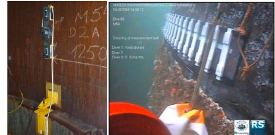
Abbildung 3: Messsystem zur Durchstrahlung des Grouts – links: Aktor am Transition Piece oberhalb des Grouts; rechts: Sensormanschette auf gereinigter Monopile-Oberfläche. Darunter die von Muscheln und Meerestieren bevölkerte MP-Oberfläche.
