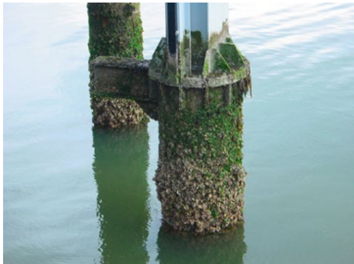
Abbildung 1: Fouling auf maritime Oberflächen (Quelle LimnoMar)
