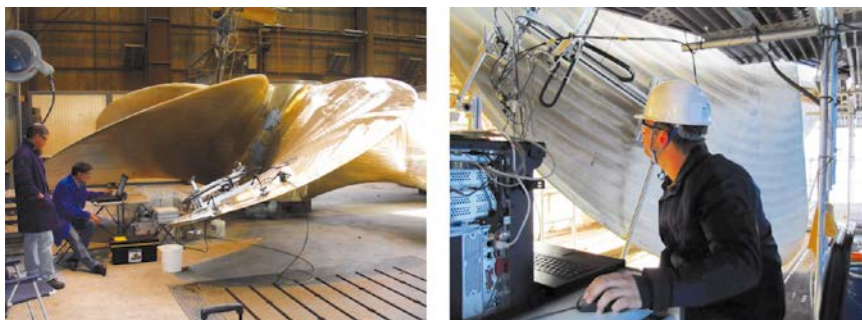
Abb. 18: Ultraschallprüfung an liegenden und montierten Propellern
