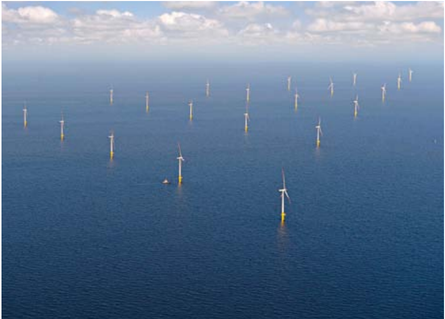
Offshore-Windpark Baltic 1 in der Ostsee
