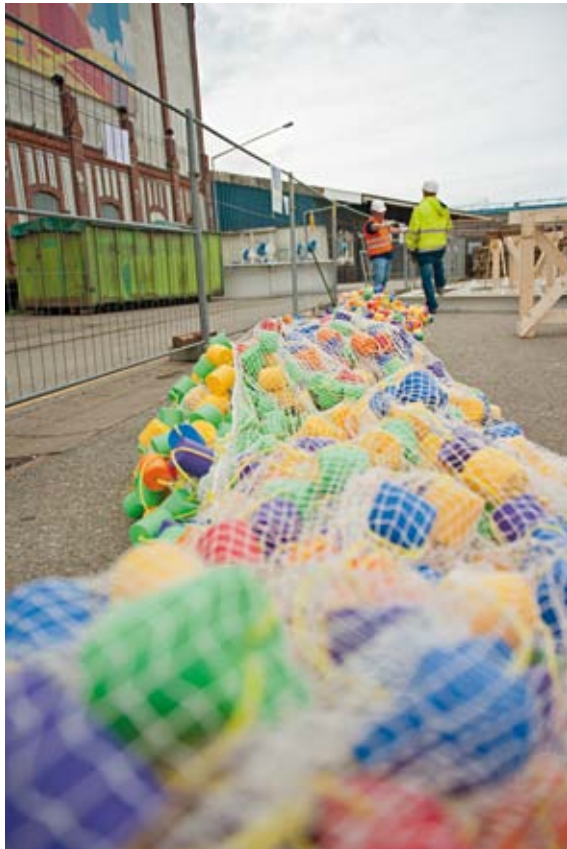
Vorbereitung des Hydroschalldämpfers beim Projekt ESRA
