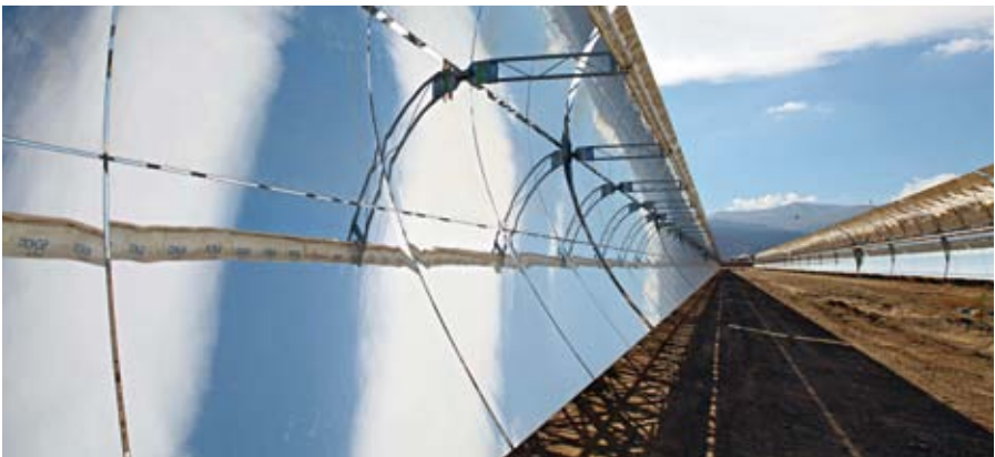
Parabolrinne des Parabolrinnenkraftwerks Andasol 3 in Granada, Spanien
