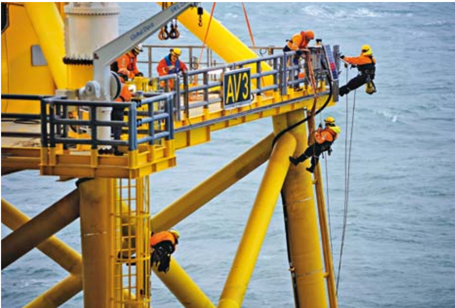
Wartungsarbeiten an alpha ventus in der Nordsee
