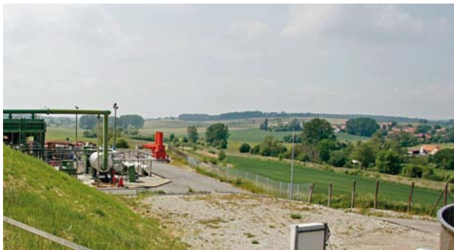
Geothermie-Kraftwerk in Soultz-sous-Forêts mit Organic-Rankine-Anlage
