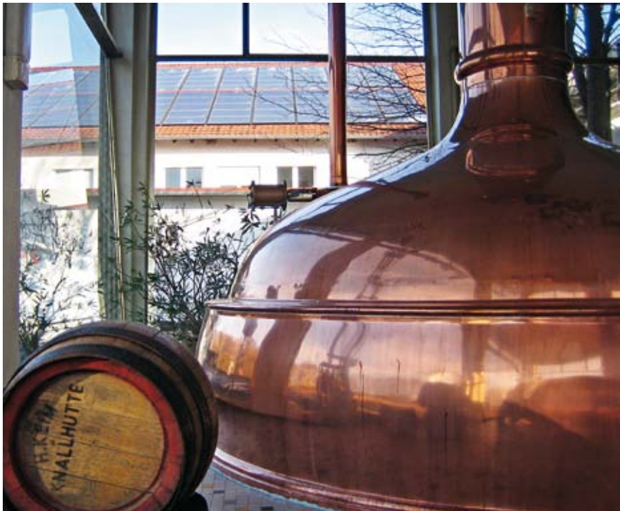
Solkollektoren der Hütt-Brauerei in Kassel-Baunatal
